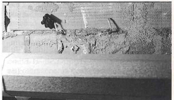
Foto 2 - Interno cassone: sul tubo esagonale si avvolge la tapparella, al di sopra i nodi di fissaggio provvisorio della scaletta.
